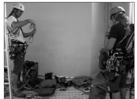
Los encargados de renovar la iluminación preparándose
